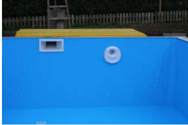
Flanscbefestigung Skimmer bei geschlossener Folie !
